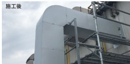
ダクトカバー施工例
