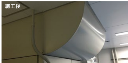
ダクトカバー施工例
